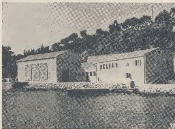
Sl. 2: HE »Zavrelje« — Strojarnica i rasklopnica
